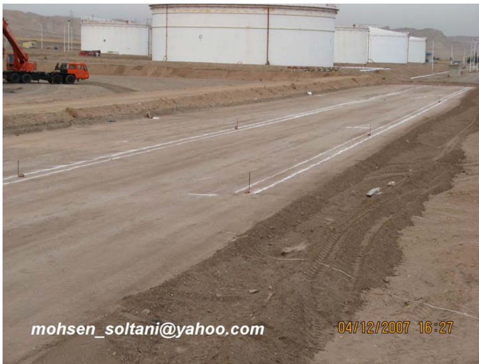
شکل ۱۹_ زیر سازی خیابان
