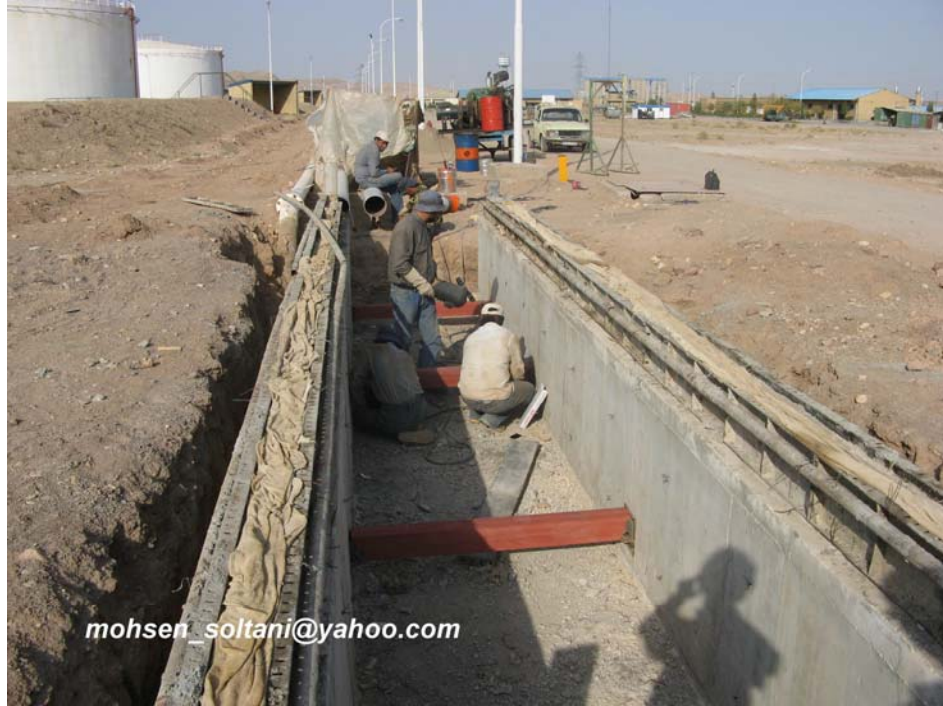
شکل ۳۱_ نصب ساپورت‌های فلزی زیر لوله های داخل پل ها
