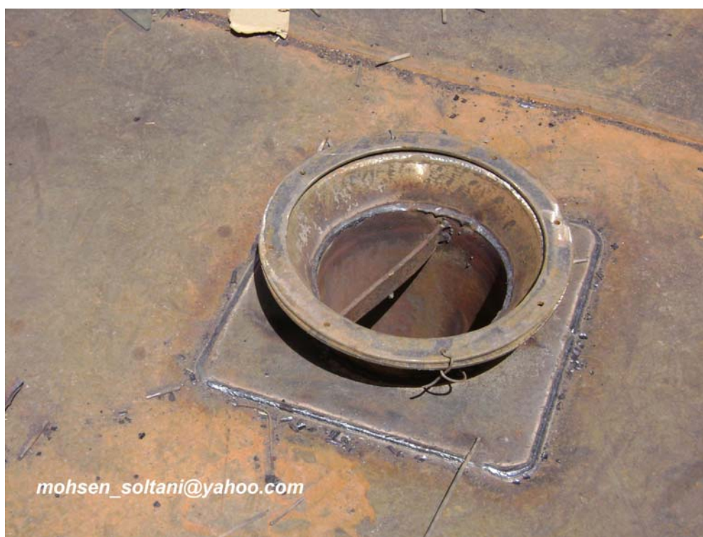
شکل ۴۰- Emergency roof drain
