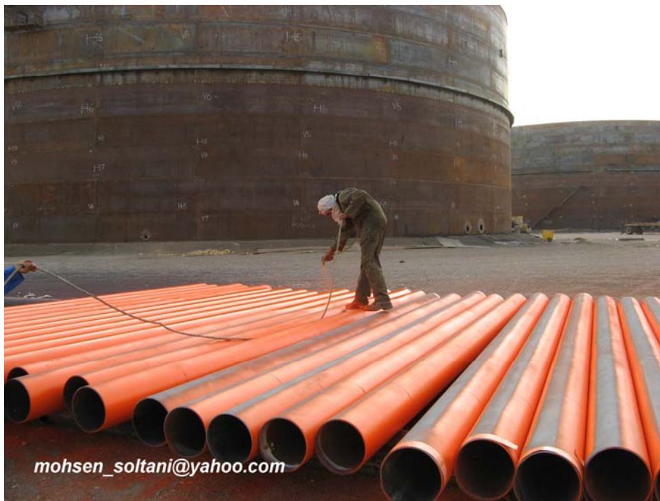
شکل ۶۸- رنگ آمیزی لایه اول رنگ لوله های سوخت
