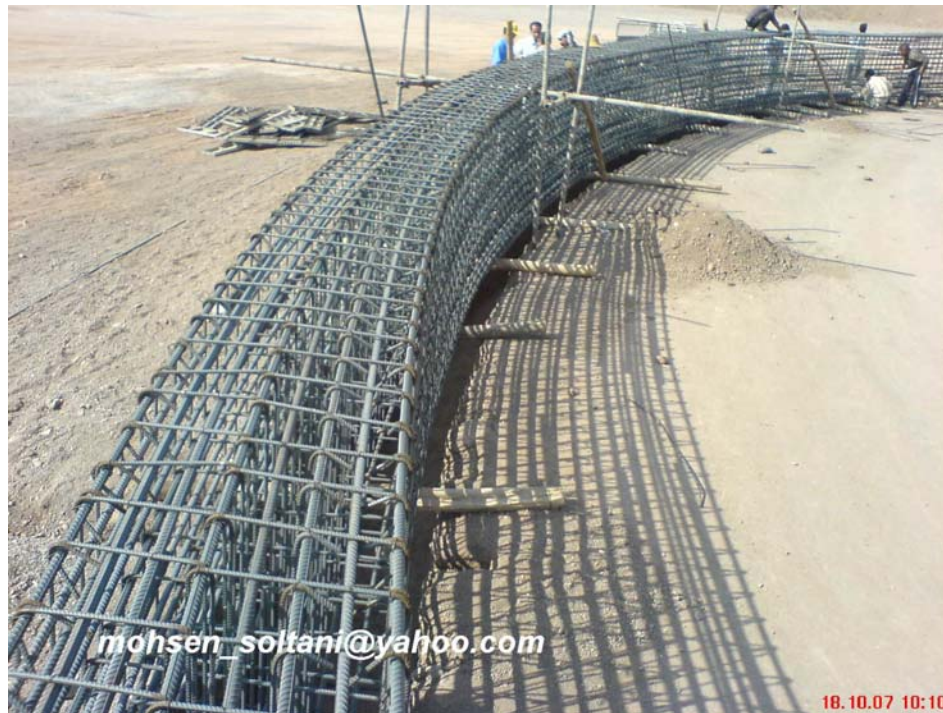
شکل ۱۱_ آماده سازی و ساخت آرماتور رینگ وال
