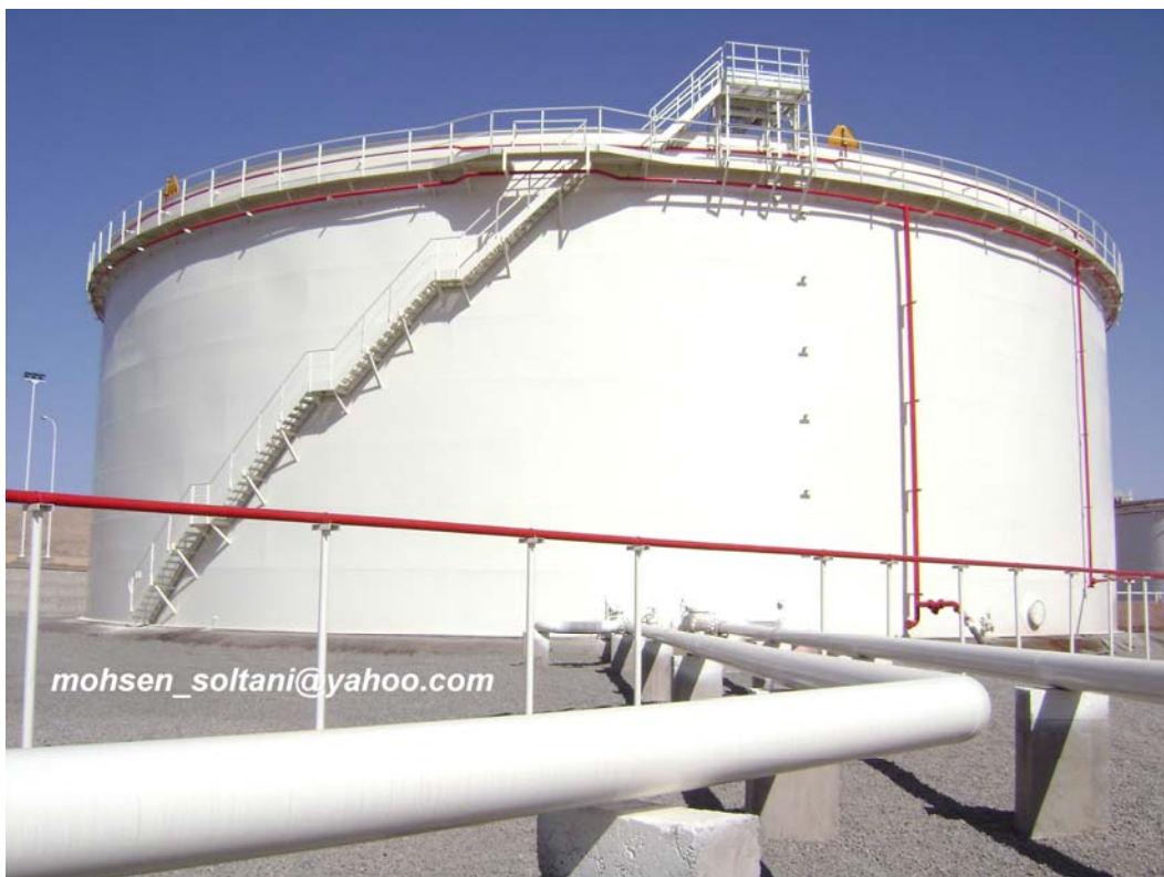
شکل ۵۷- تکمیل رنگ لایه نهایی بدنه مخزن
