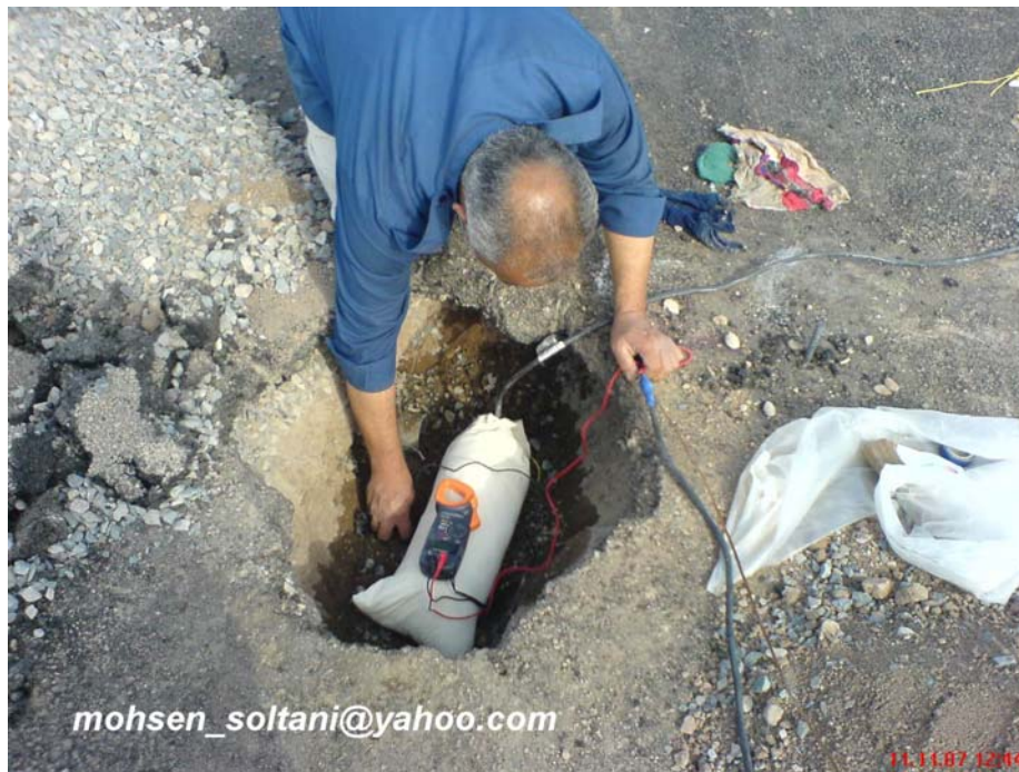
شکل ۲۷_ اجرای سیستم حفاظت کاتدیک ( نصب الکتروود مرجع )
