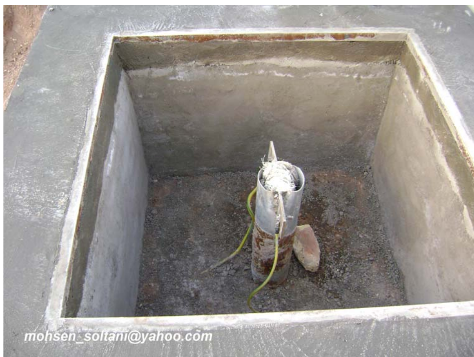
شکل ۲۸- حوضچه مربوط به چاه سیستم ارتینگ
