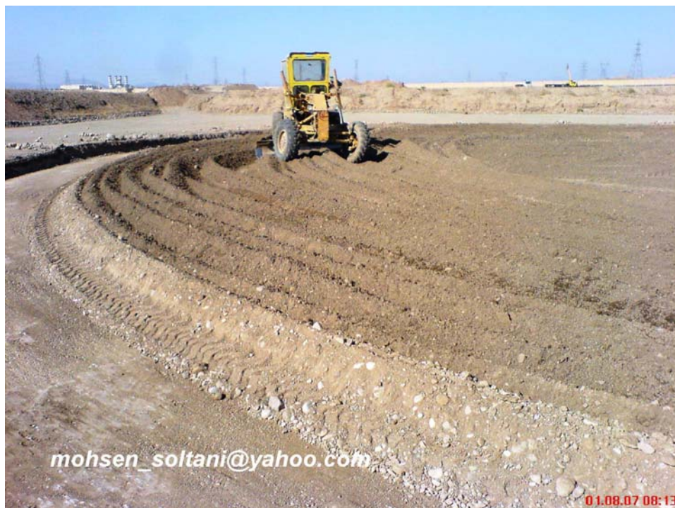
شکل ۶- عملیات خاکریزی زیر مخزن
