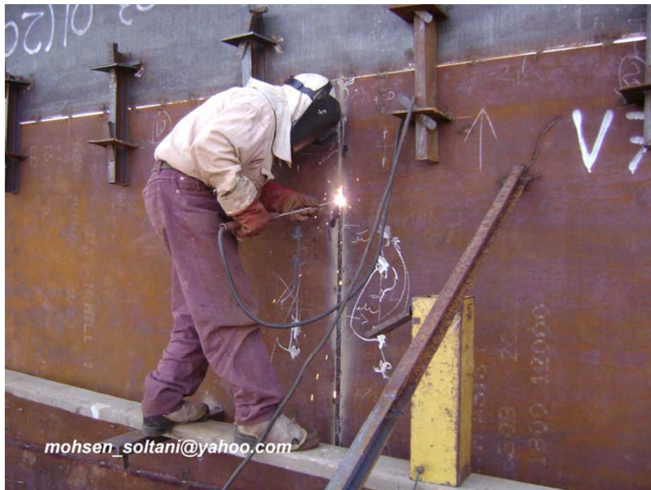
شکل ۲۲- عملیات جوشکاری Backweld
