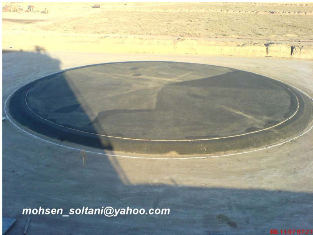
شکل ۱۷- آسفالت زیر مخزن
