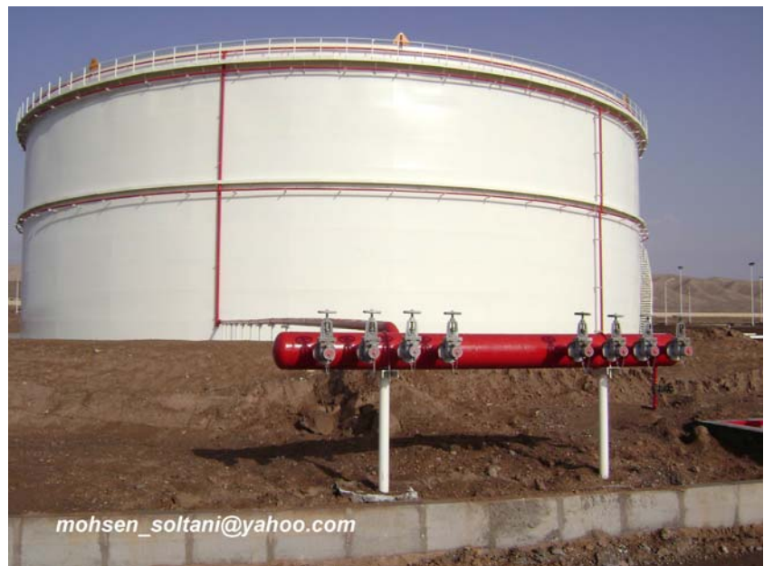
شکل ۶۳- سیستم Foam
