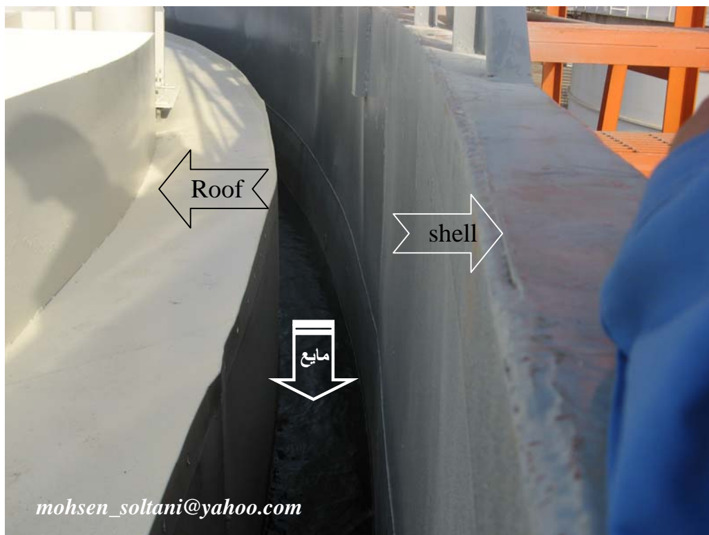
شکل ۵۲- شناور شدن سقف مخزن
