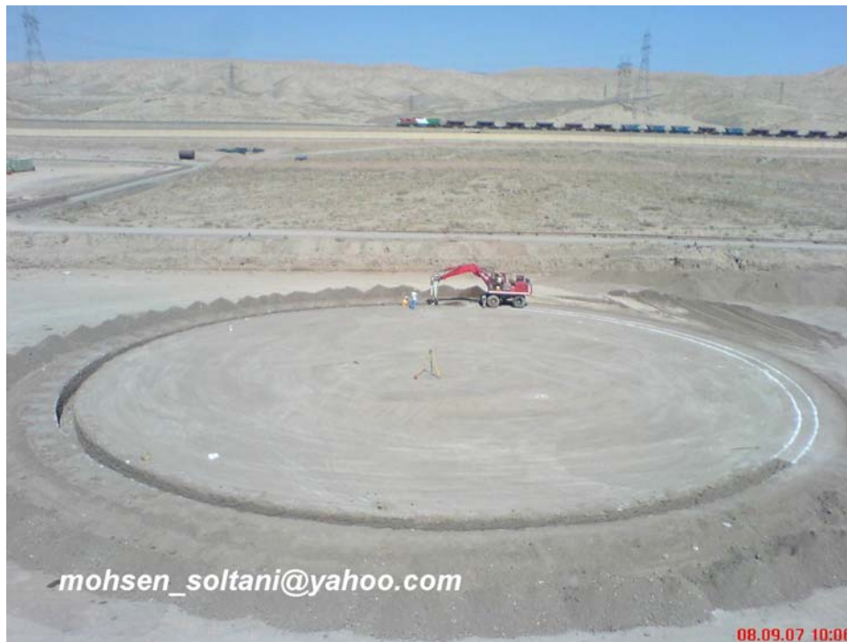
شکل ۹- عملیات حفر کانال رینگ
