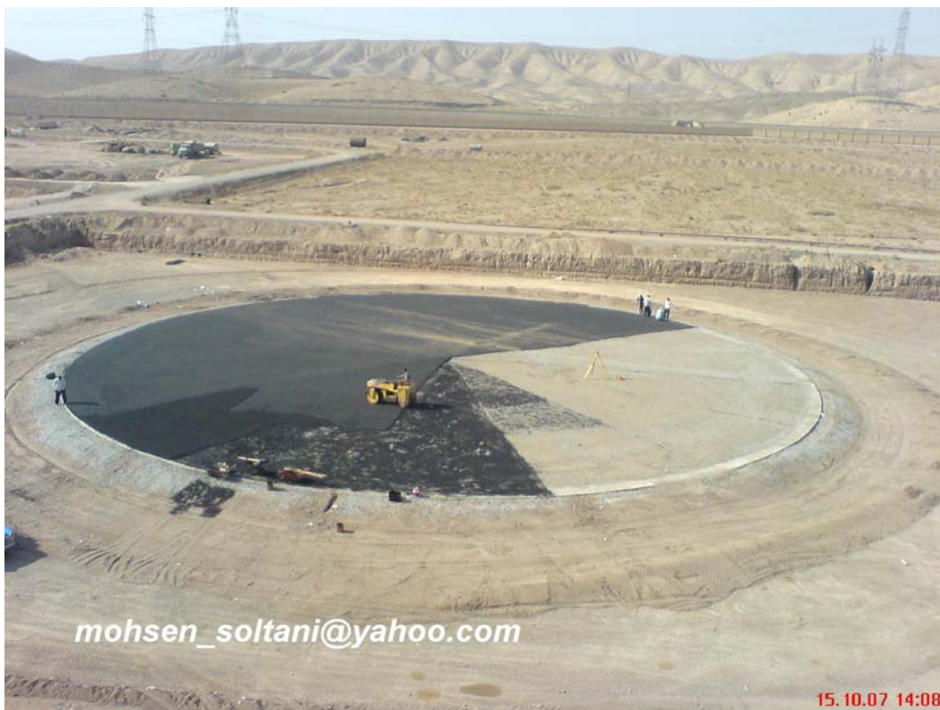
شکل ۱۶- اجرای لایه آسفالت
