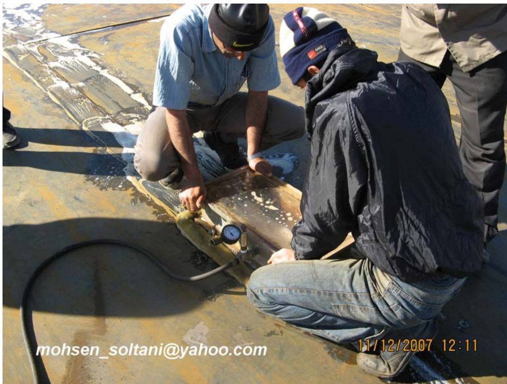
شکل ۱۱- عملیات تست و کیوم ورقهای کف مخزن
