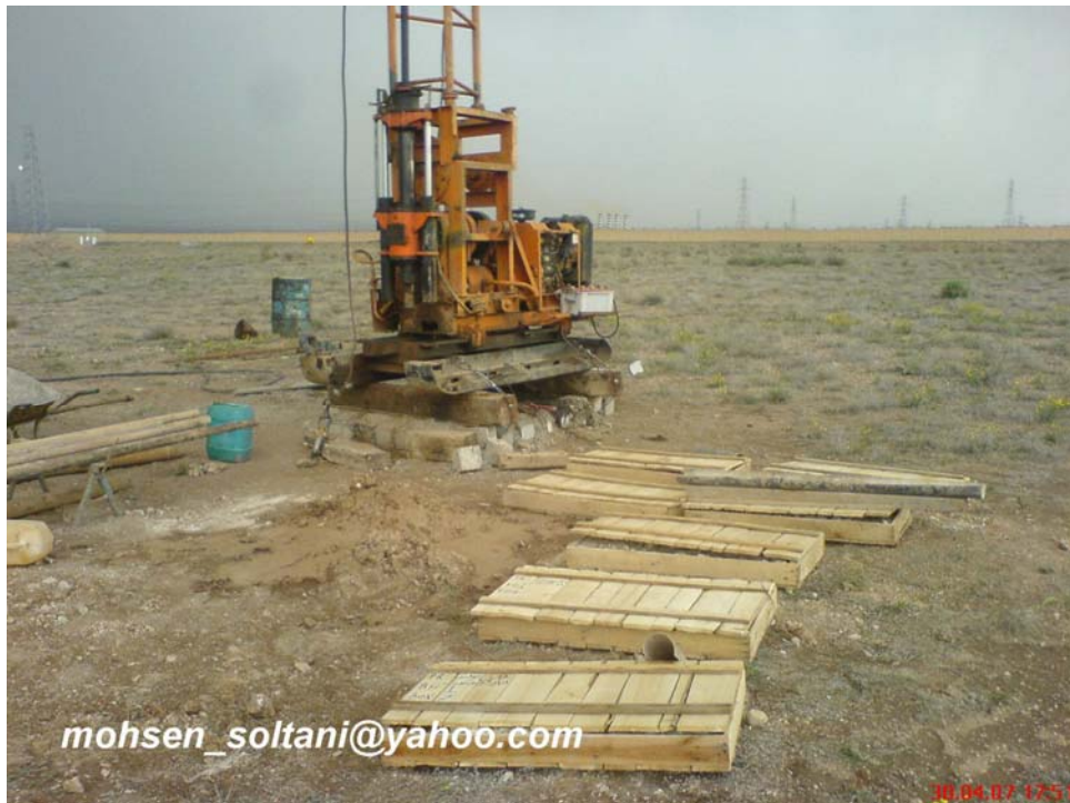
شکل ۱- عملیات گمانه زنی اولیه
