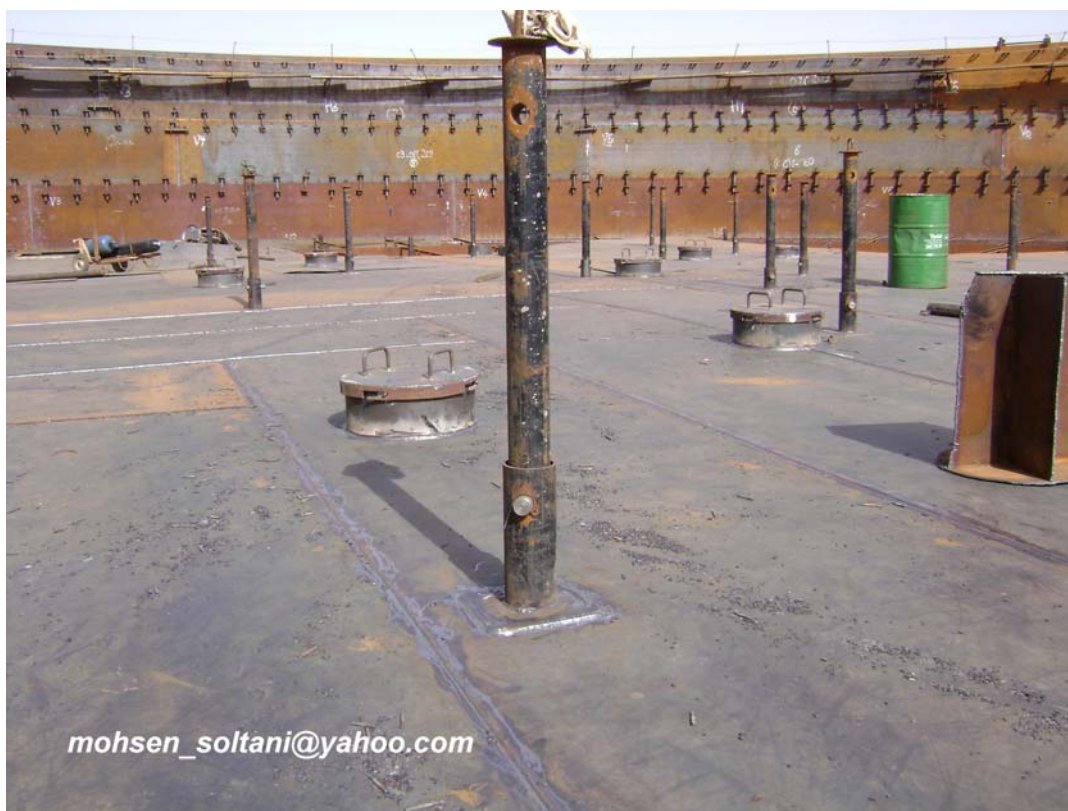
شکل ۳۴- ساپورت‌های سقف شناور
