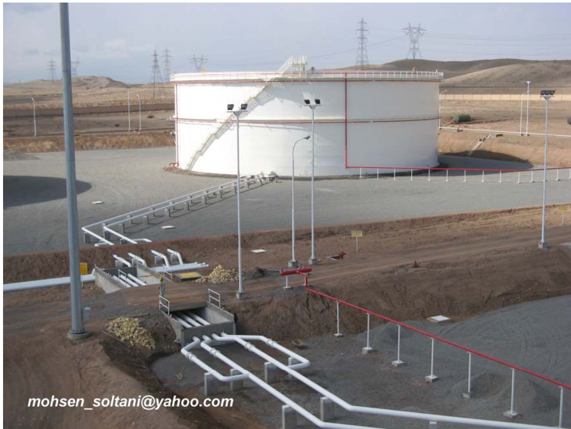
شکل ۷۱- مخازن تکمیل شده پس از شن ریزی
