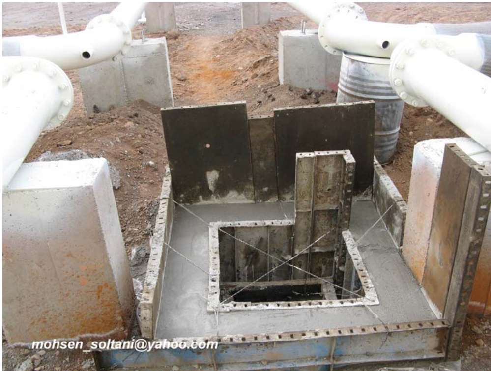
شکل ۶۴- ساخت Pit خط لوله OilyDrain
