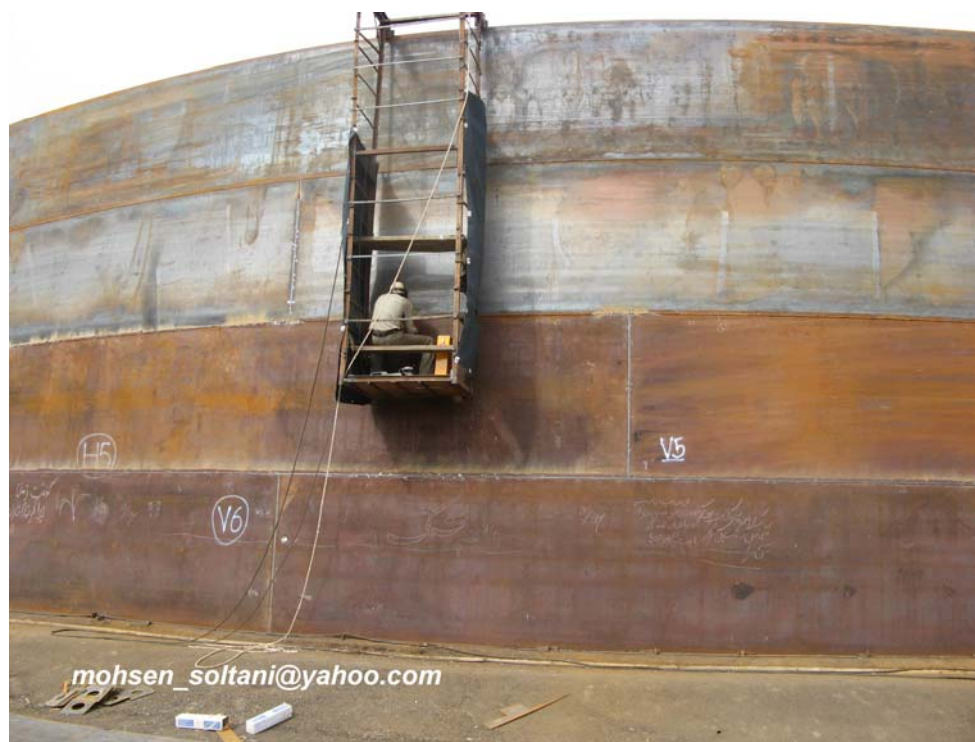
شکل ۲۴- عملیات جوشکاری ورقهای Shell
