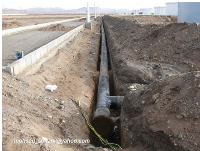
شکل ۵۹- خط لوله آتش نشانی
