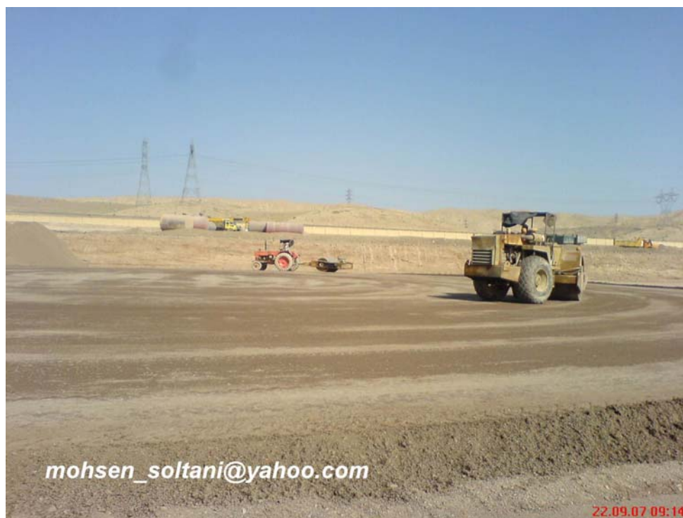
شکل ۷- عملیات کوبش خاکریزی زیر مخزن
