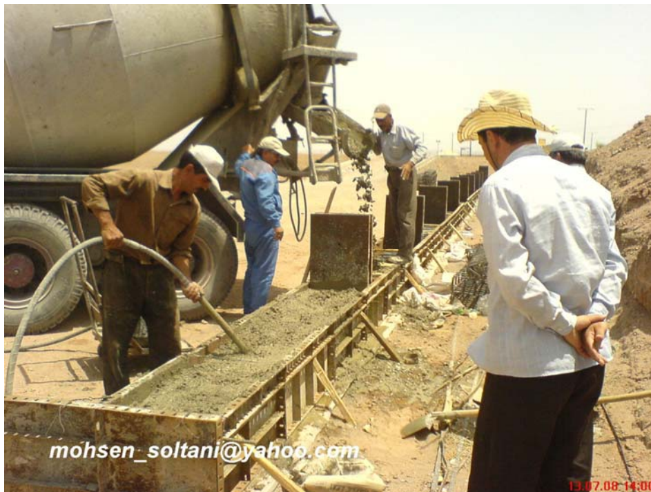
شکل ۳۲_ بتن ریزی slab
