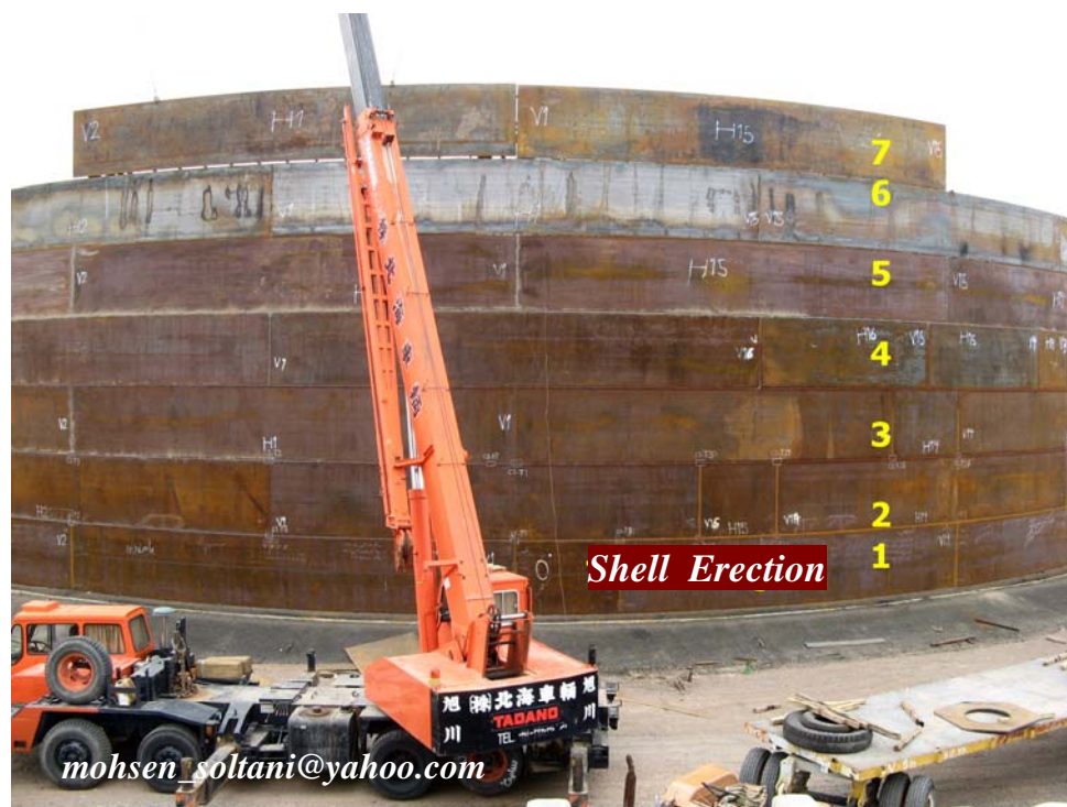
شکل ۲۳- مونتاژ و نصب ورقهای Shell
