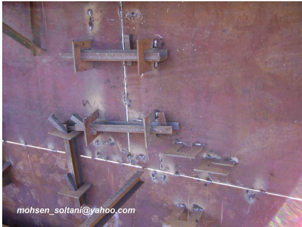
شکل ۱۸- رعایت فاصله بین ورقها (Gap)
