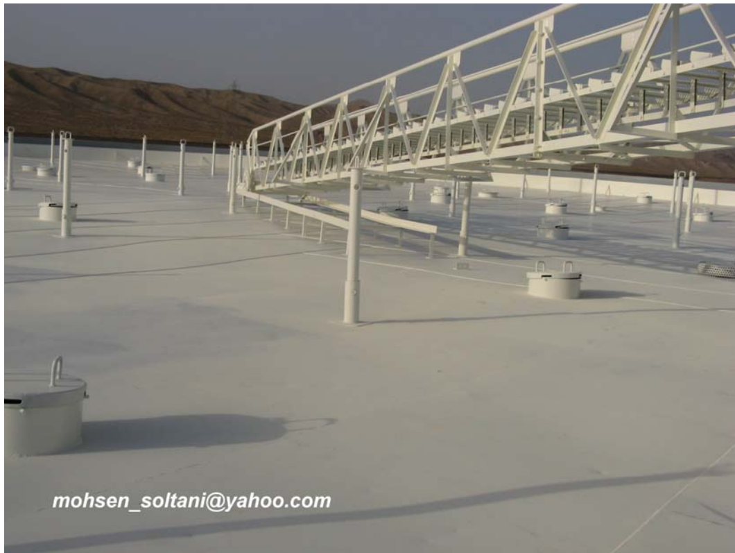
شکل ۵۳- تکمیل هیدروتست و شناور شدن سقف مخزن در بالاترین حد آن
