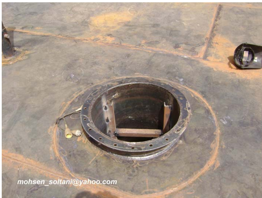
شکل ۳۶- Roof manhole
