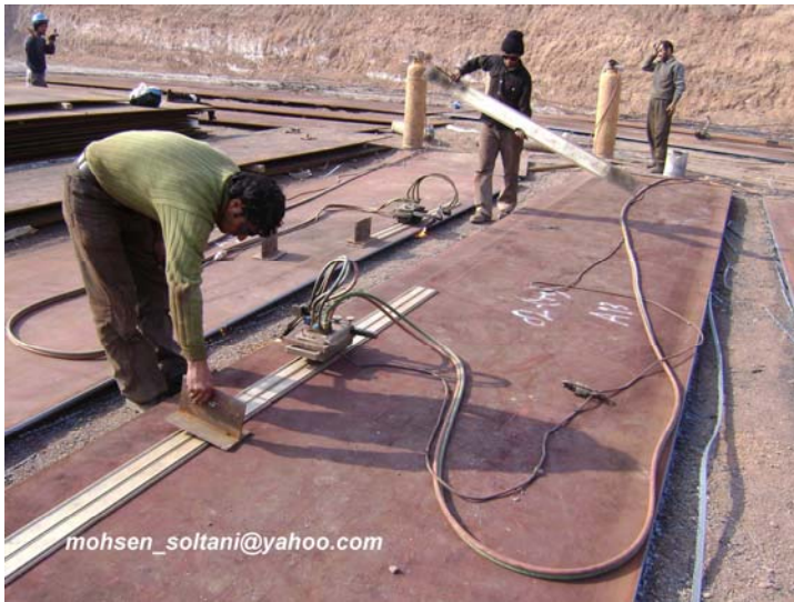
شکل ۸ - برشکاری و گونیا کردن ورقها
