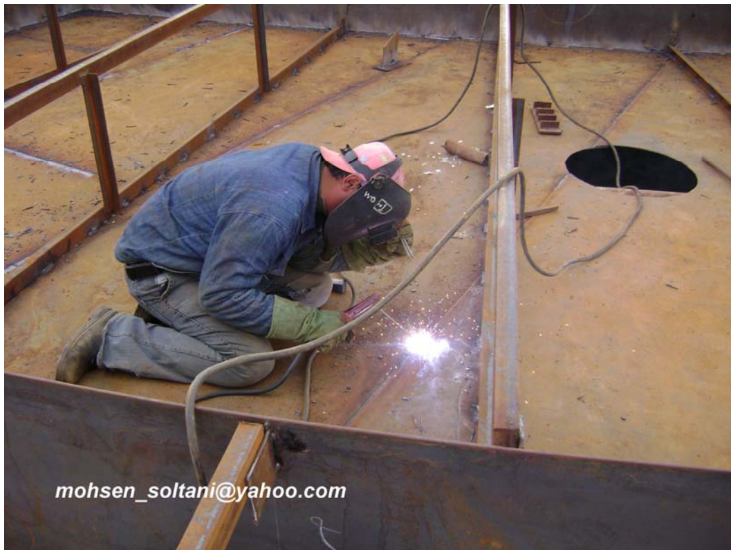
شکل ۱۳- عملیات جوشکاری lower deck
