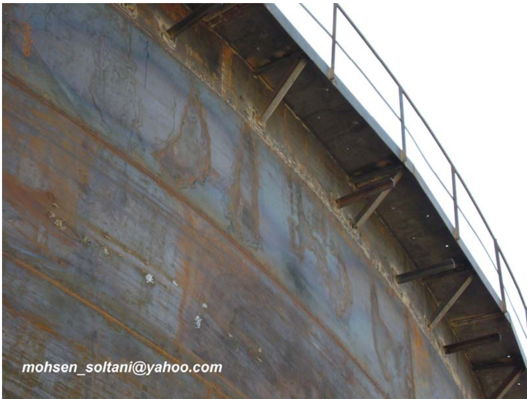
شکل ۴۶- Windgirder نصب و جوش شده
