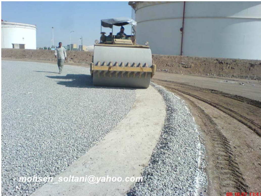
شکل ۱۵- اتوکشی سطح تمام شده شن (لایه فیلتر)
