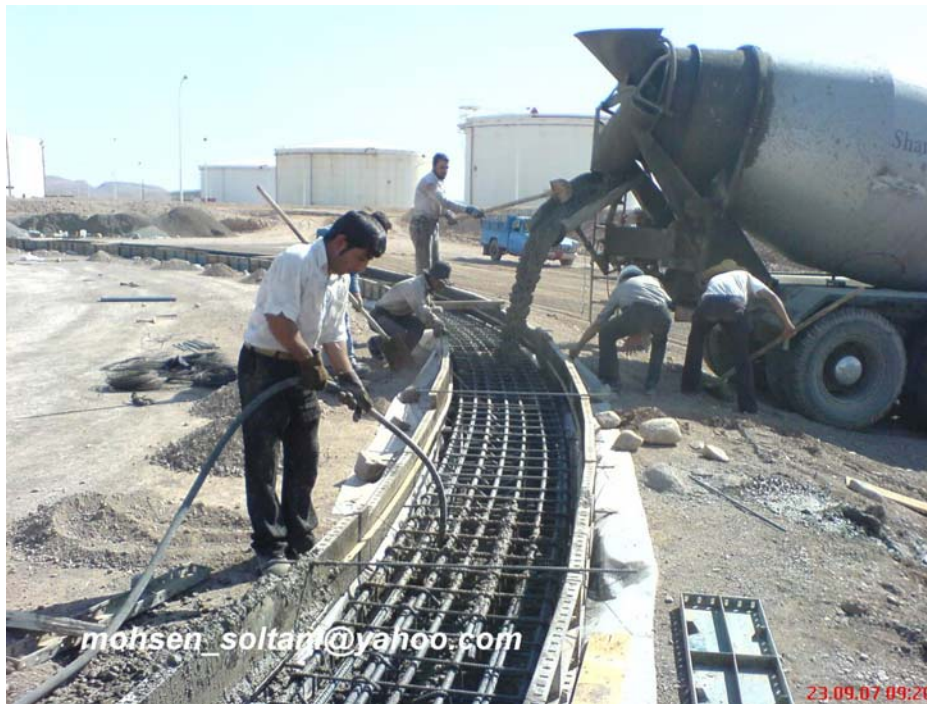
شکل ۱۳- بتن ریزی رینگ وال
