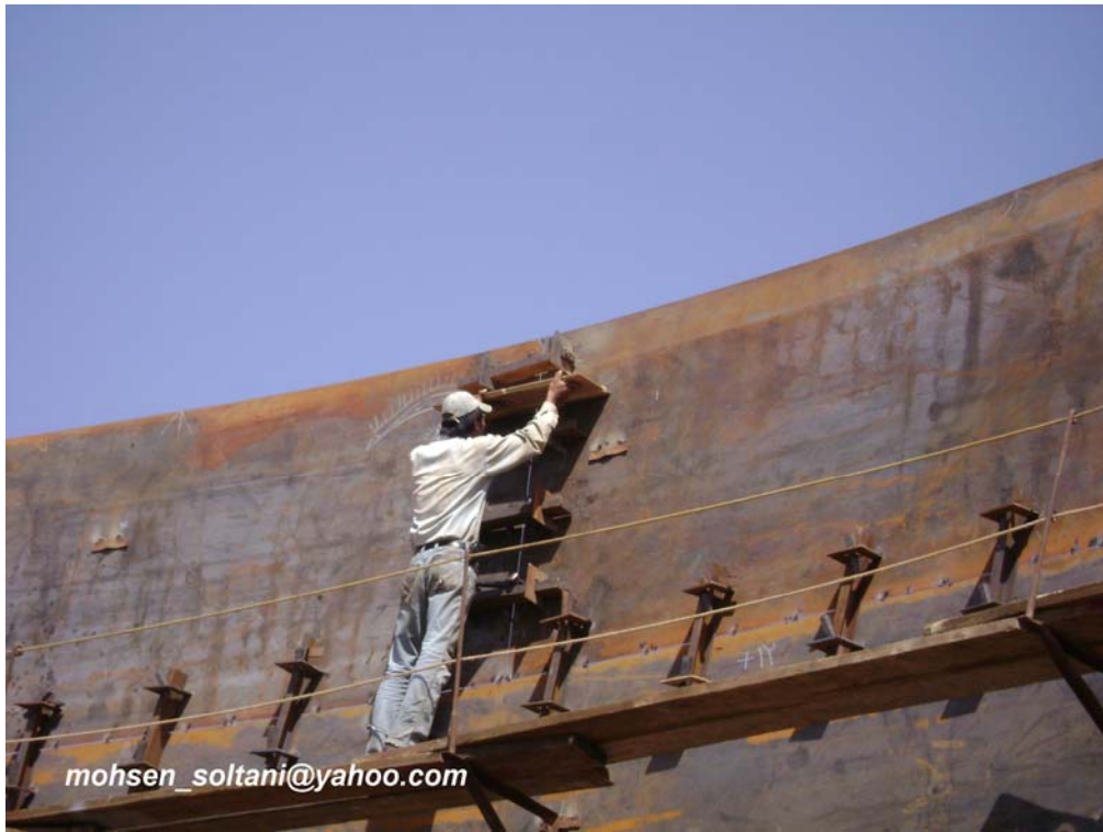
شکل ۳۱- تست Peaking
