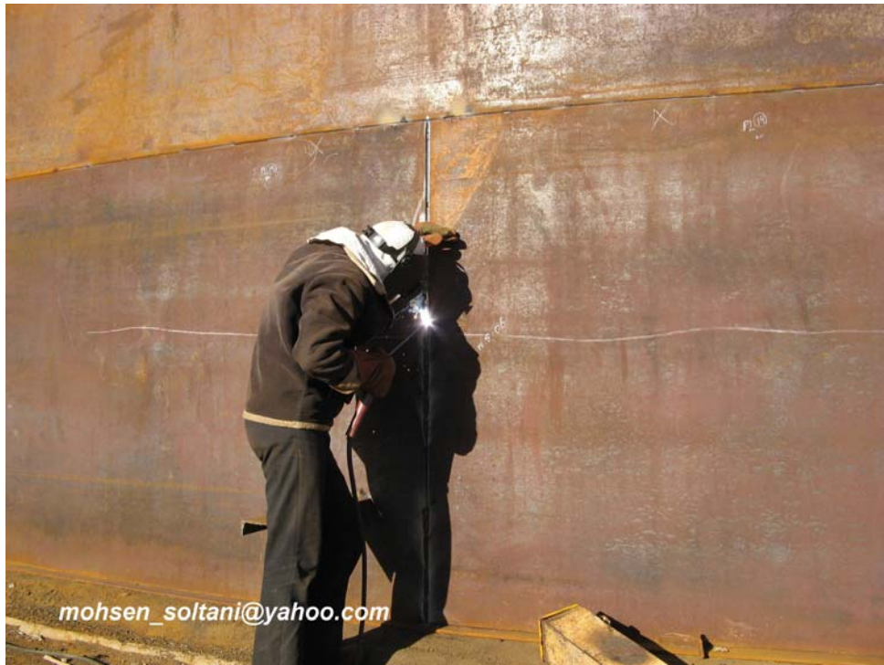
شکل ۲۰- جوشکاری درزهای عمودی کورس اول
