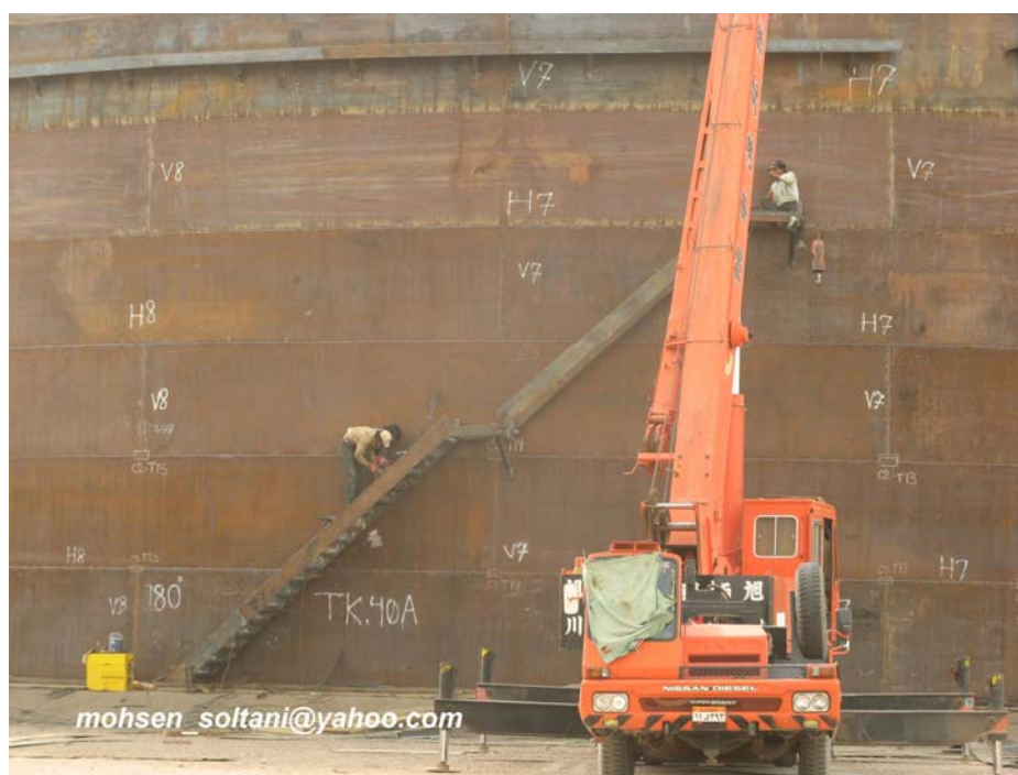
شکل ۴۹ - نصب پله‌های بیرونی بدنه مخزن
