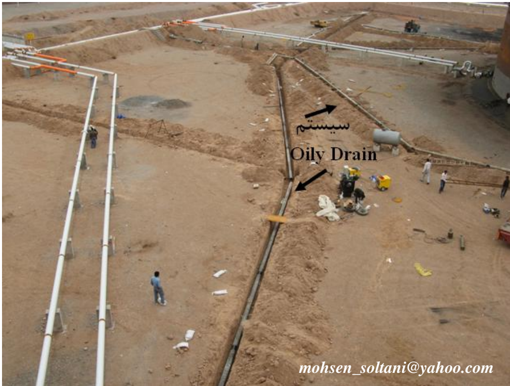
شکل ۶۶- خط لوله سیستم OilyDrain
