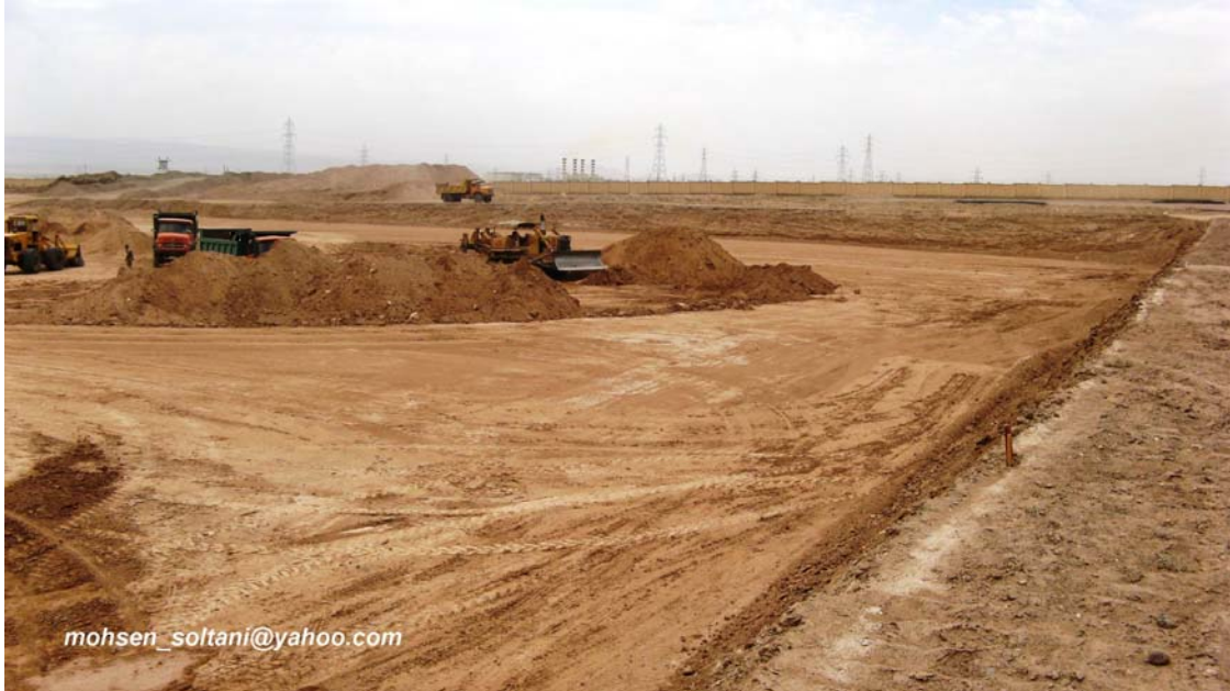
شکل ۴- عملیات خاکبرداری سایت
