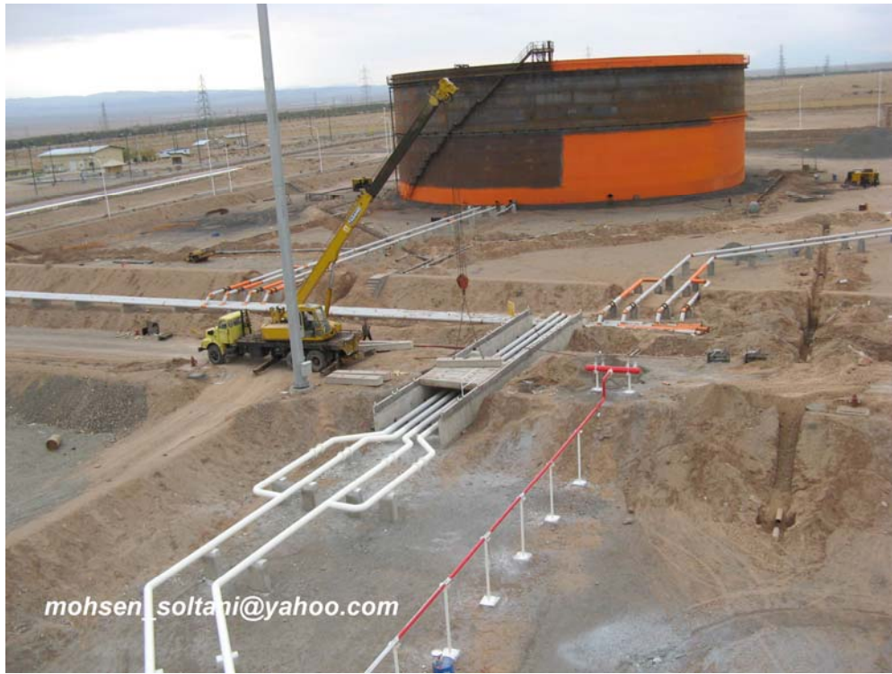
شکل ۳۳_ قرار دادن Slab ها بر روی پل
