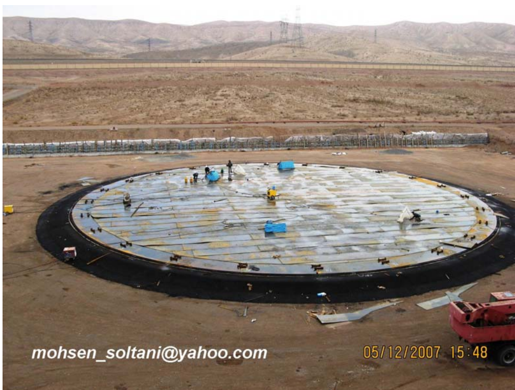
شکل ۴_ تکمیل چیدمان ورقهای کف
