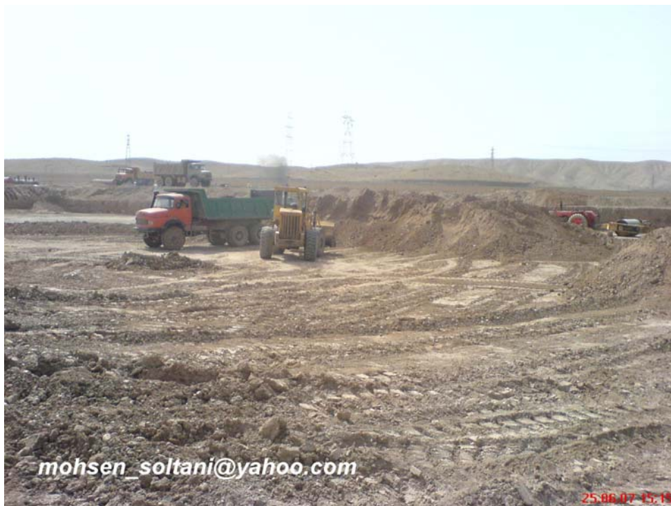
شکل ۵- عملیات خاکبرداری زیر مخزن
