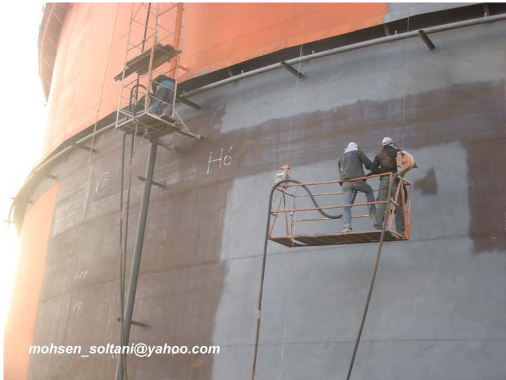
شکل ۵۴- سندبلاست بدنه مخزن
