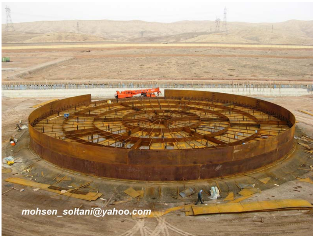
شکل ۱۴- مونتاژ Rim ، Truss و Compartment
