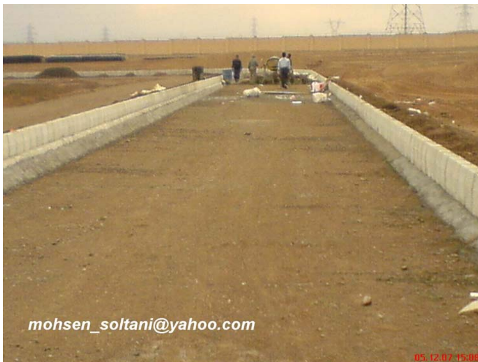
شکل ۲۰_ نصب جدول خیابان
