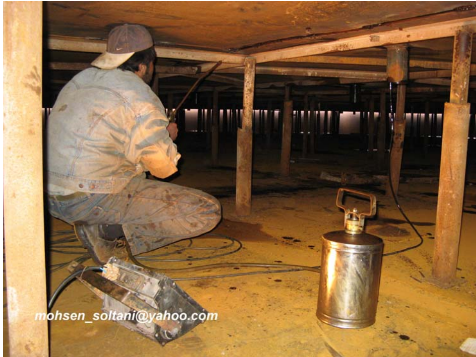
شکل ۲۹- عملیات تست گازوییل
