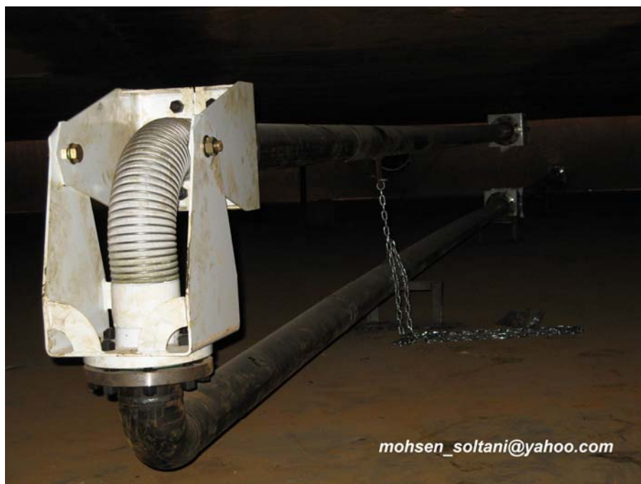
شکل ۳۷- لوله Roof drain
