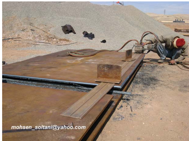
شکل ۹ - پخ زدن لبه ورقها
