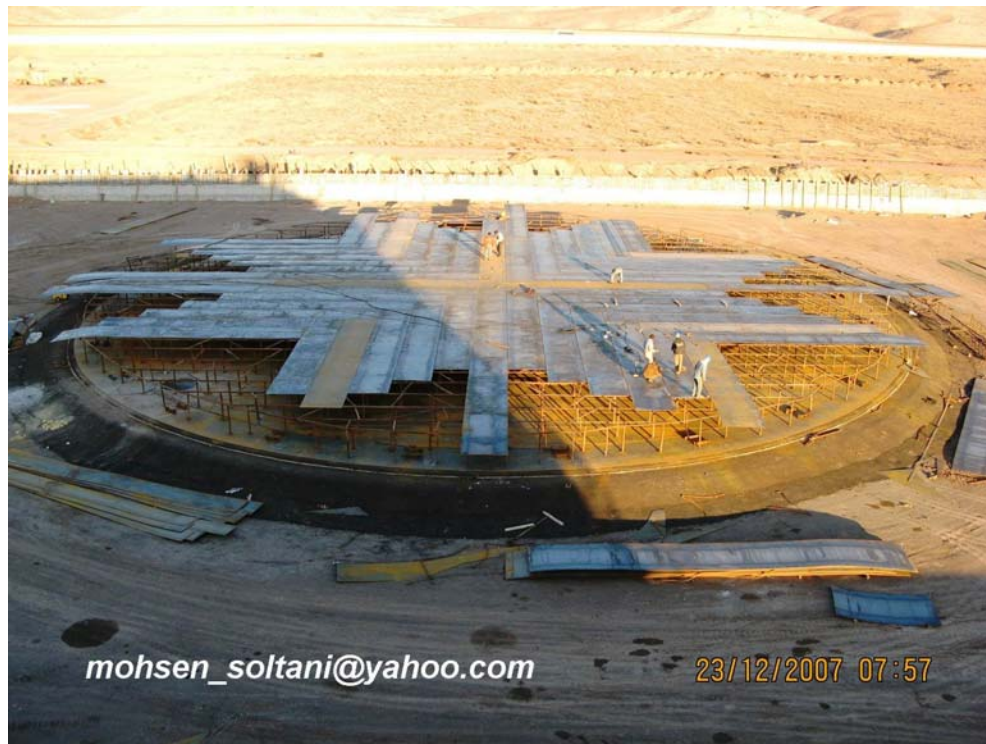
شکل ۱۲- عملیات چیدمان ورقهای Lower Deck
