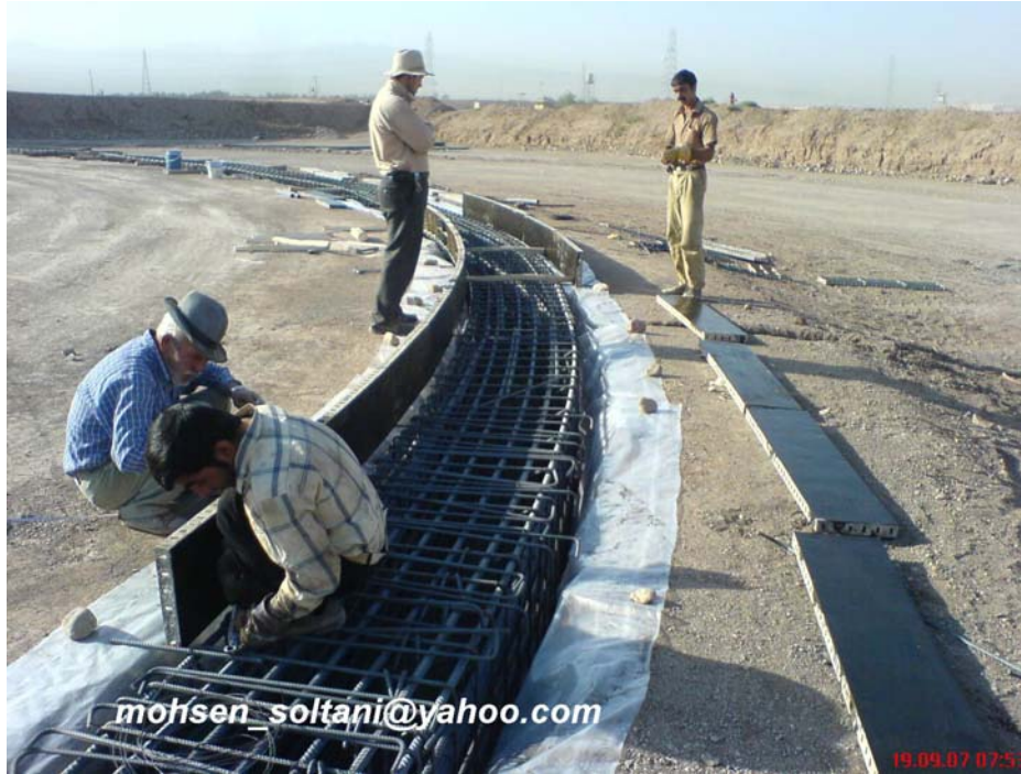
شکل ۱۲- آرماتوربندی رینگ وال
