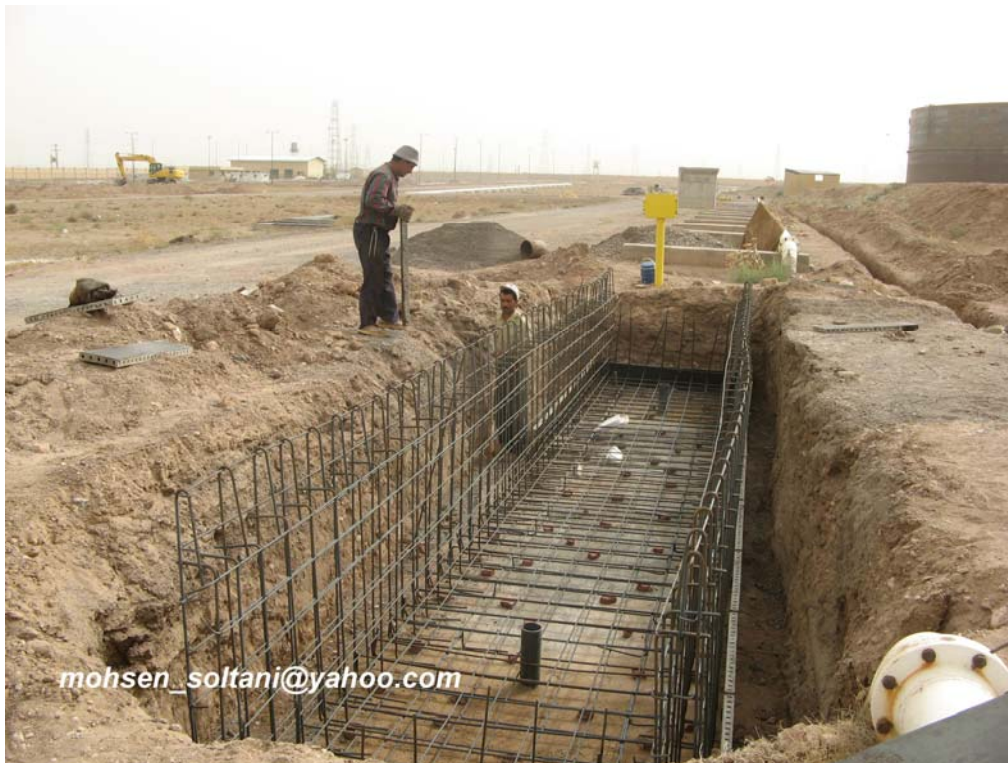
شکل ۳۰_ آرماتور بندی پل
