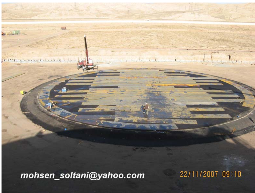
شکل ۳_ عملیات چیدمان ورقهای کف
