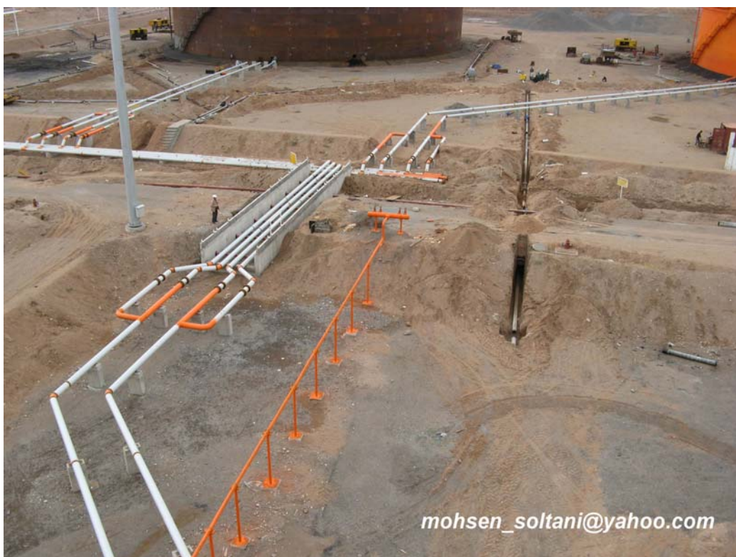
شکل ۶۹- خط لوله سوخت
