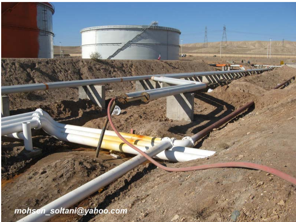
شکل ۷۰- آبیگری خط لوله سوخت جهت هیدروتست
