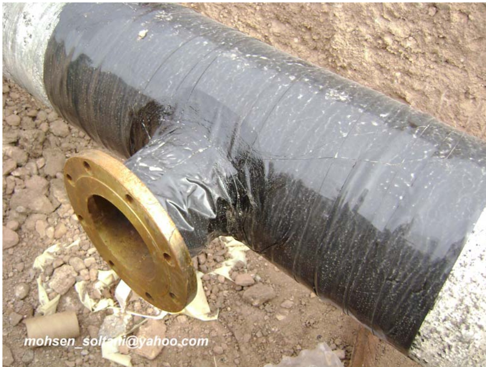
شکل ۶۷- عایق کاری لوله های خط آتش نشانی
