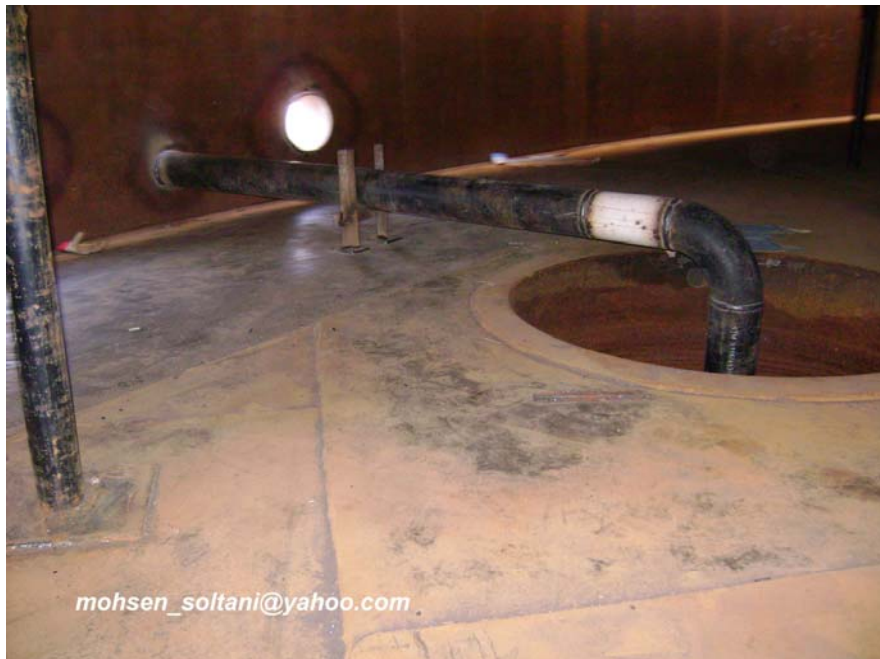
شکل ۴۳- سیستم Draw of sump
