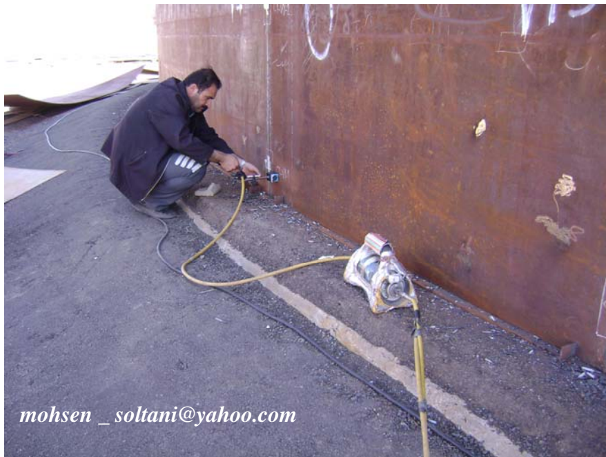
شکل ۲۸- تست رادیوگرافی
