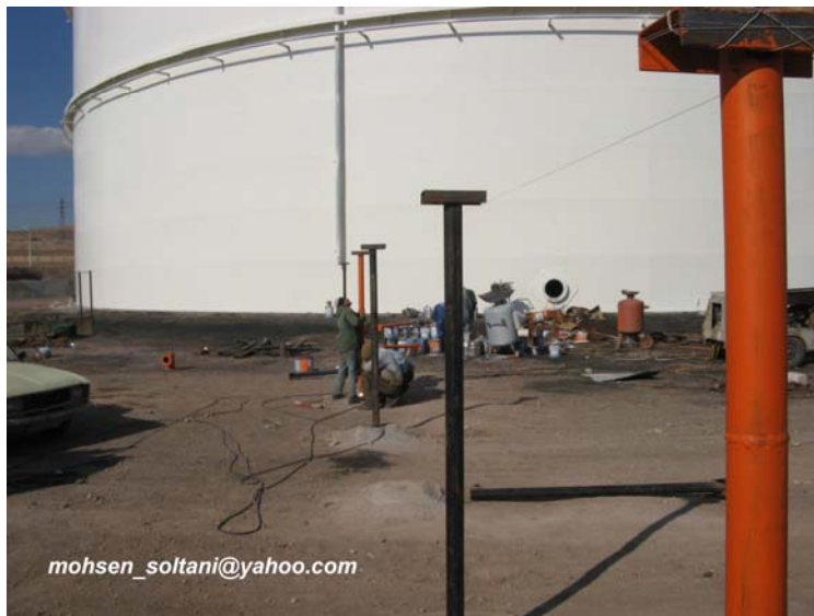
شکل ۶۲- نصب ساپورتهای خط لوله سیستم فوم
