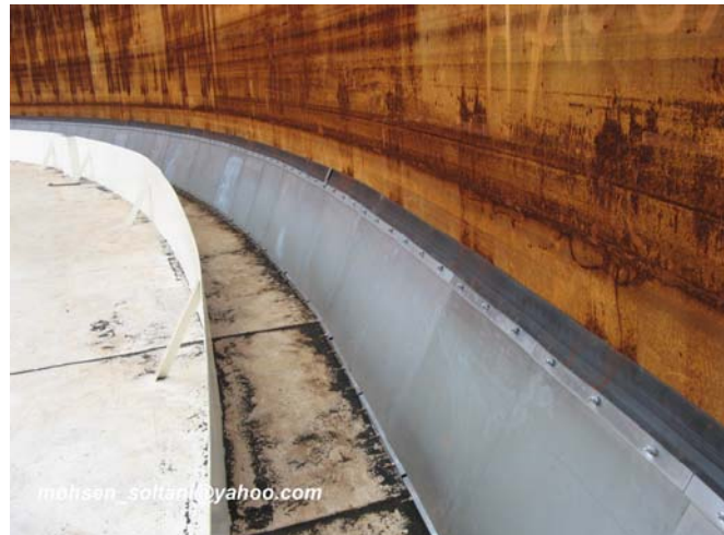
شکل ۴۲- سیستم تکمیل شده Seal سقف شناور
