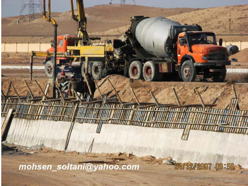
شکل ۲۱_ عملیات بتن ریزی دیوار حائل
