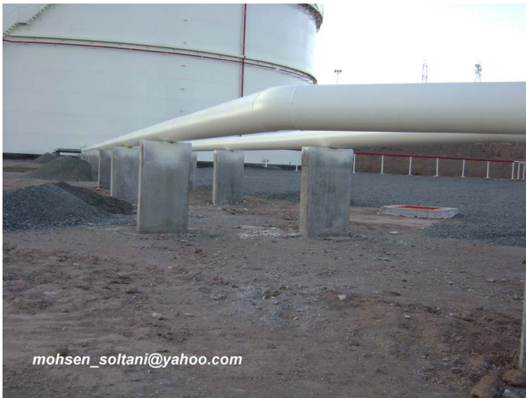
شکل ۳۵- ساپورتهای بتنی زیر لوله فرآورده
