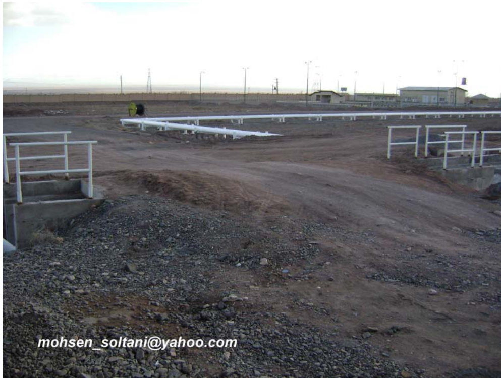
شکل ۳۴_ گاردهای فلزی روی پل
