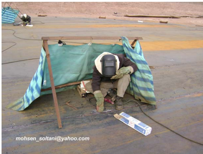
شکل ۵- جوشکاری ورقهای Bottom plate
